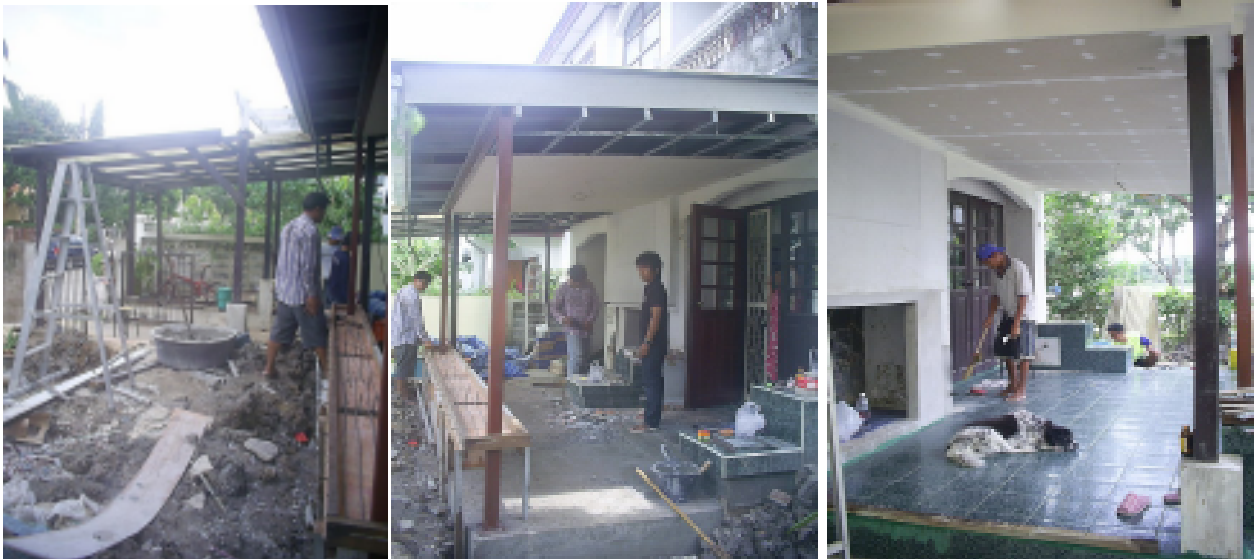
ช่วงดำเนินการก่อสร้าง
